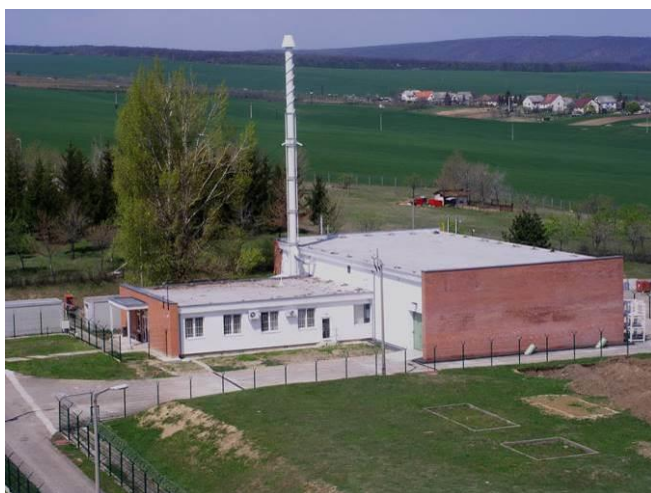
Ulaz u postrojenje, u pozadini naselje Püspökszilágy
