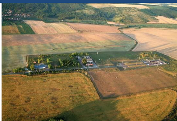
Postrojenje za obradu i odlaganje radioaktivnog otpada (Püspökszilágy)
